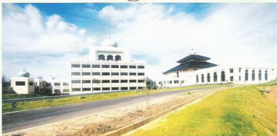
Kompleks Jabatan Mufti Kerajaan, Jabatan Perdana Menteri yang terletak di Jalan Pengiran Babu Raja.
